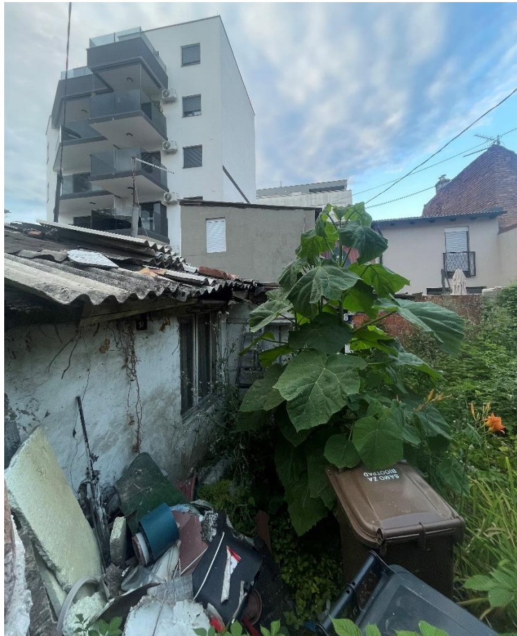
Slika 11. Napuštena kućica nasuprot višestambene zgrade (Autorska fotografija, 16. lipnja 2025.)
