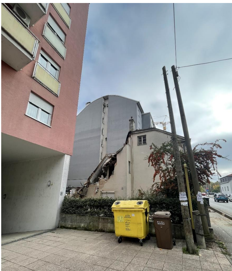
Slika 14. Rušenje kuće u Nehajskoj (Autorska fotografija, 26. listopada, 2024.)
