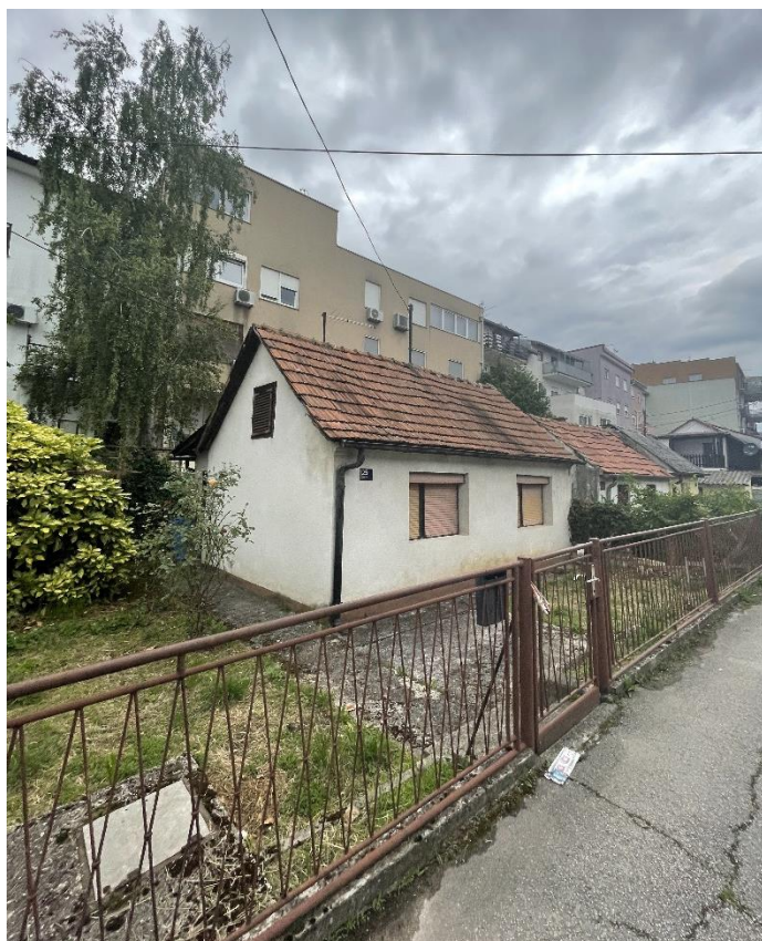
Slika 16. Prizemnica u Čapljinjskoj ulici (Autorska fotografija, 16. svibnja 2024.)
